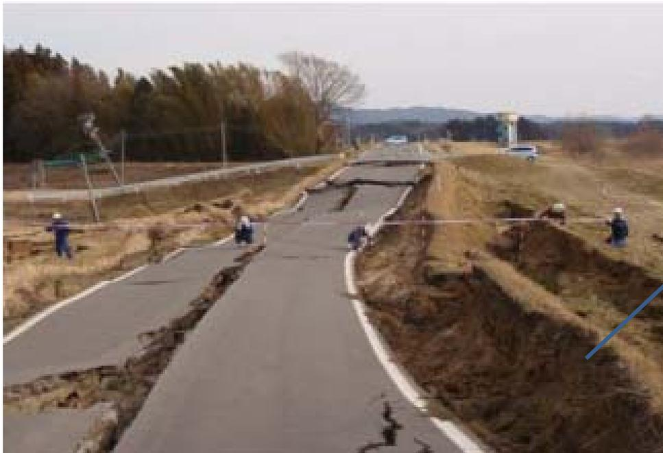
液状化により堤防が沈下・変形・弱体化(堤体土の川表側へ著しい変形)
