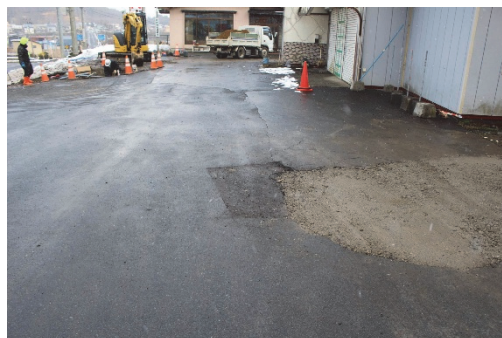
写真6 道路宅地側での管路の修復状況
