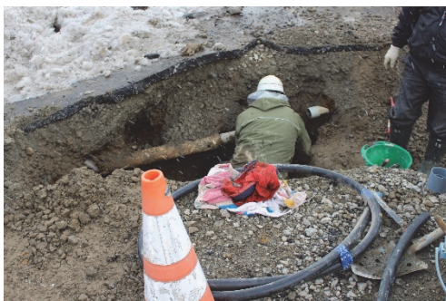
写真6 道路宅地側での管路の修復状況
