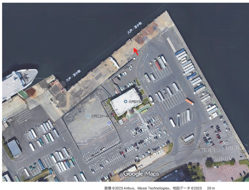
写真 8 八戸 FT での被害位置詳細写真（Google Maps より）
