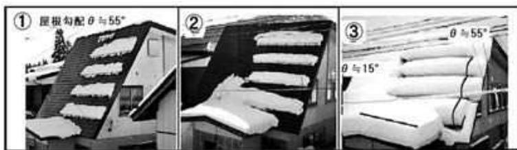
図7 日本古来の屋根雪止め工法(柵高が小さくとも安定)
