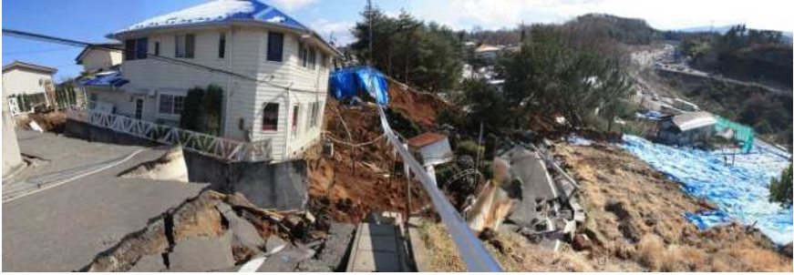
写真3 宅地盛土の崩壊(末端部は国道まで流出した)
