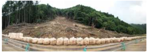
写真5 豪雨による斜面崩壊(末端部は国道まで流出)
