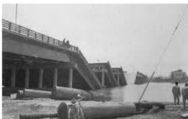
図 1 (左) 川岸町アパートの転倒 (右) 昭和大橋の落橋
