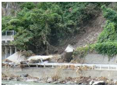
図3 斜面崩壊
