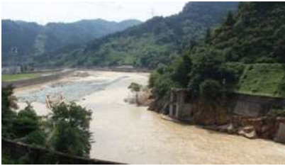
写真4 洪水により流出した鉄橋
