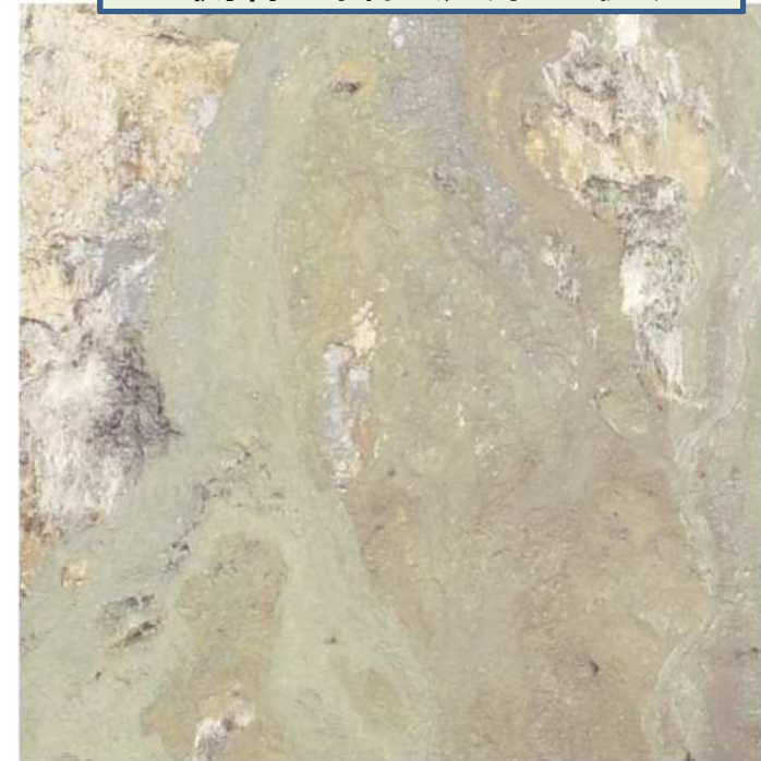
A側線 斜面泥濘化状況
