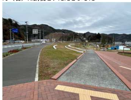
防潮堤に頼らないまちをコンセプトに国道398号と防潮堤が一体構造となっています
