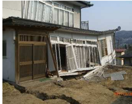
写真2 地震による被害例
