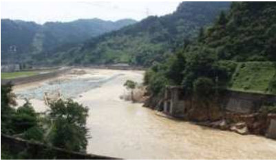
写真4 洪水により流出した鉄橋
