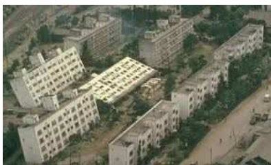
図 1 (左) 川岸町アパートの転倒 (右) 昭和大橋の落橋
