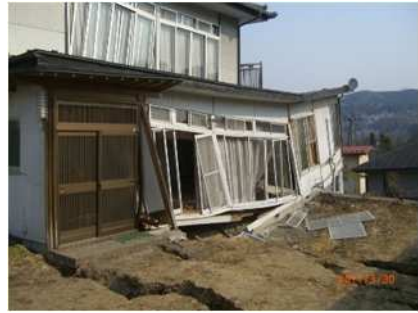
写真2 地震による被害例
