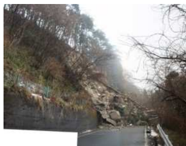
写真2 道路切土斜面の崩壊
