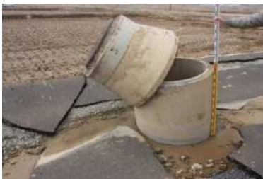
写真1 液状化によるマンホールの浮き上がり
