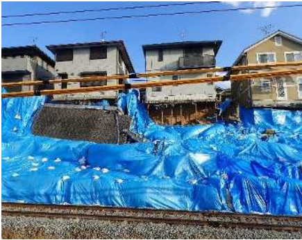
写真1 豪雨による被害例
