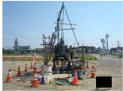
図1 ボーリング調査
