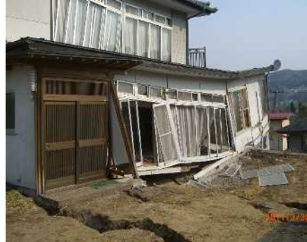
写真2 地震による被害例
