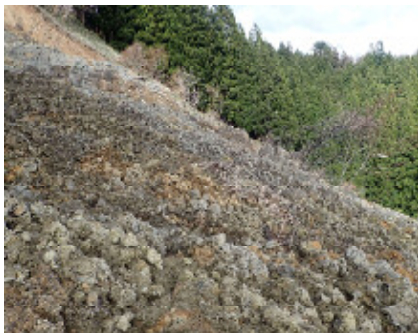
含水による泥濘化状況
