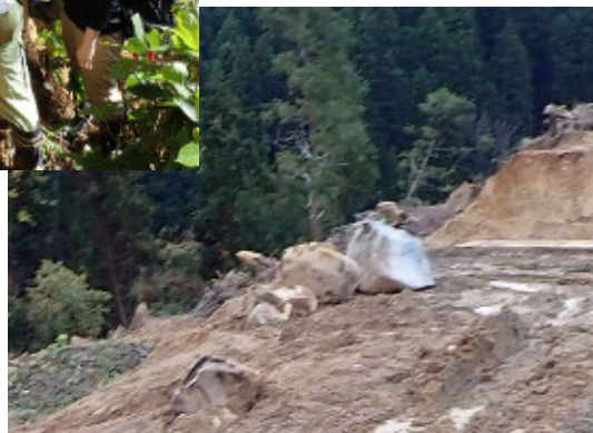
法面掘削時に掘り出された安山岩の岩塊
