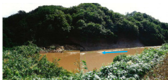
崩壊直後の状況
