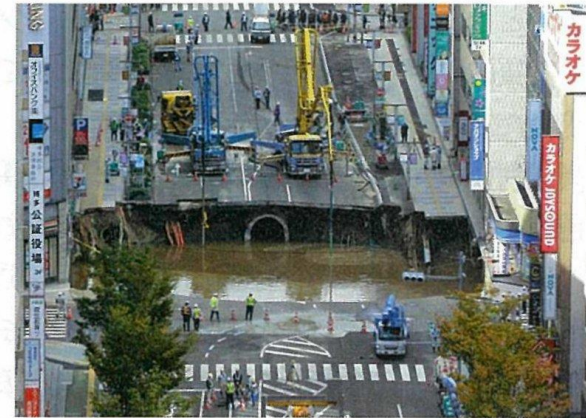
JR博多駅前で発生した道路陥没事故の様子(写真:本誌)
