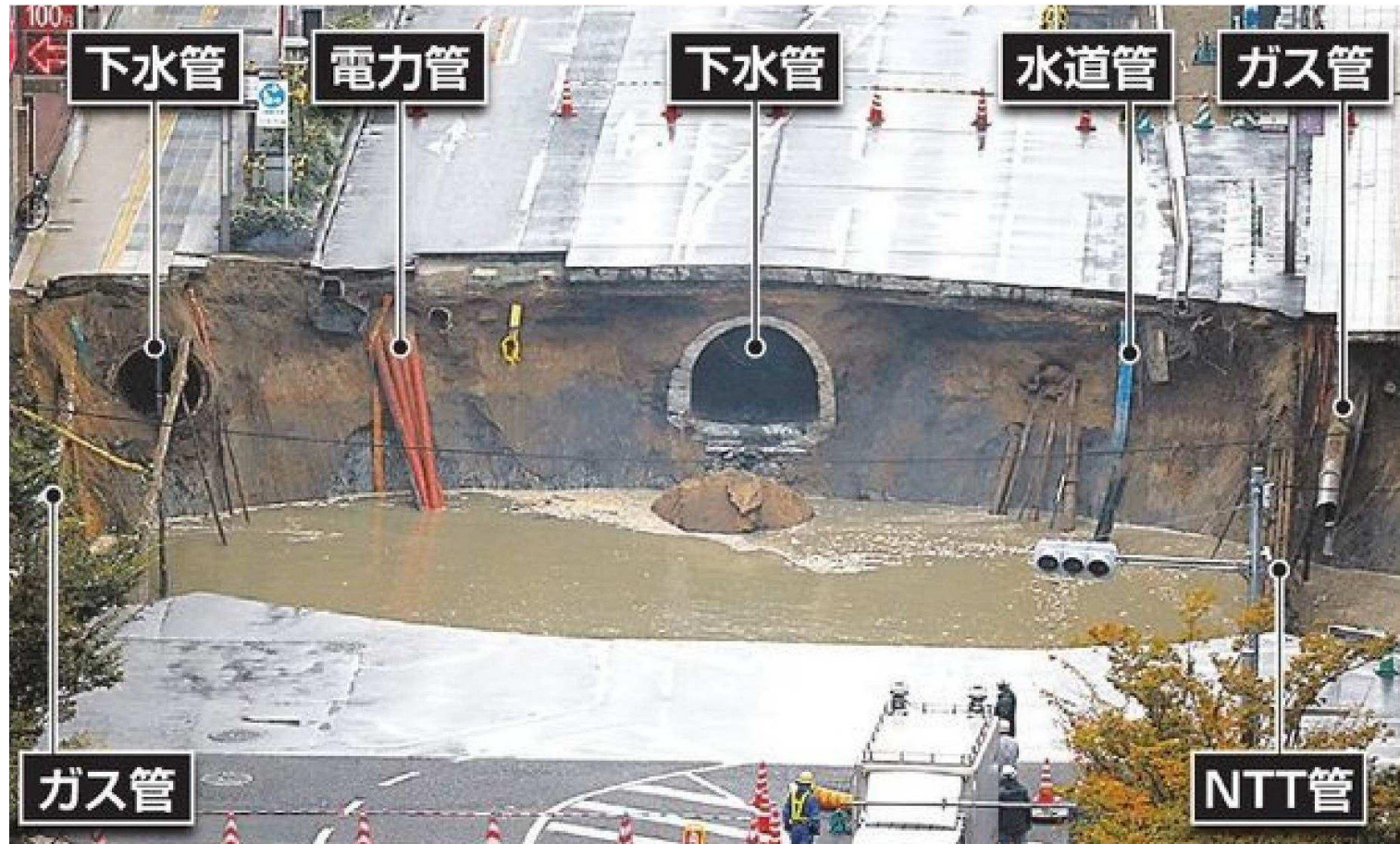
2016年11月8日 博多駅前陥没事故 朝日新聞デジタルより
