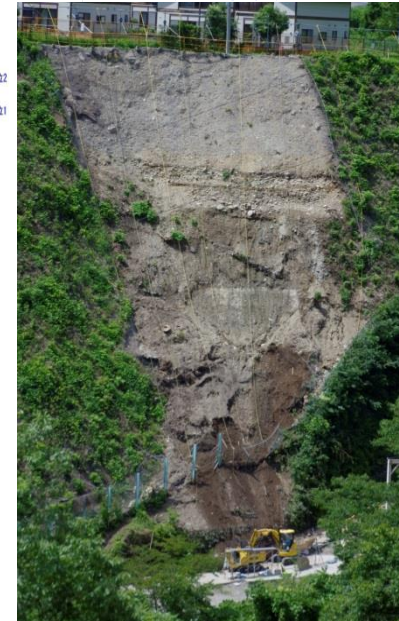
C 斜面の表土処理および排土工状況 (2018年8月)
