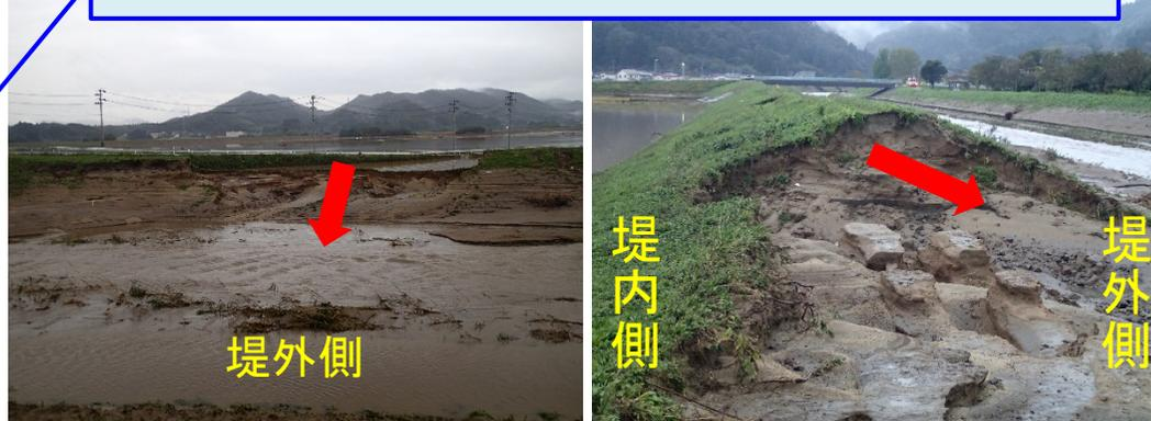
↑ 上流での河川氾濫に伴う堤内側の浸水に伴う破堤と推察される. 通常の堤防の決壊とは逆方向の破堤.
